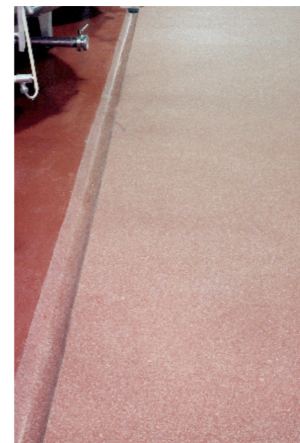
Kunstharzgebundener Estrich mit geschliffener Oberfläche
