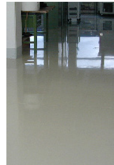
Ableitfähige Kunstharzbeschichtungen z.B. nach EN 61340 T4/T5
